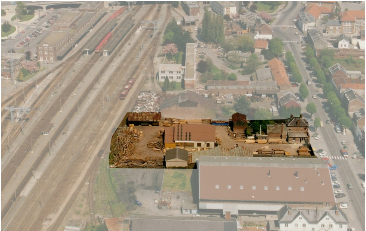
Vue aérienne, vers 1989 (BM Saint-Quentin).
