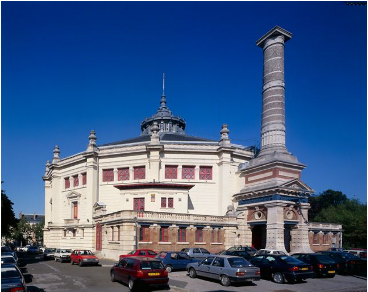
Vue de l'élévation postérieure avec la cheminée.
