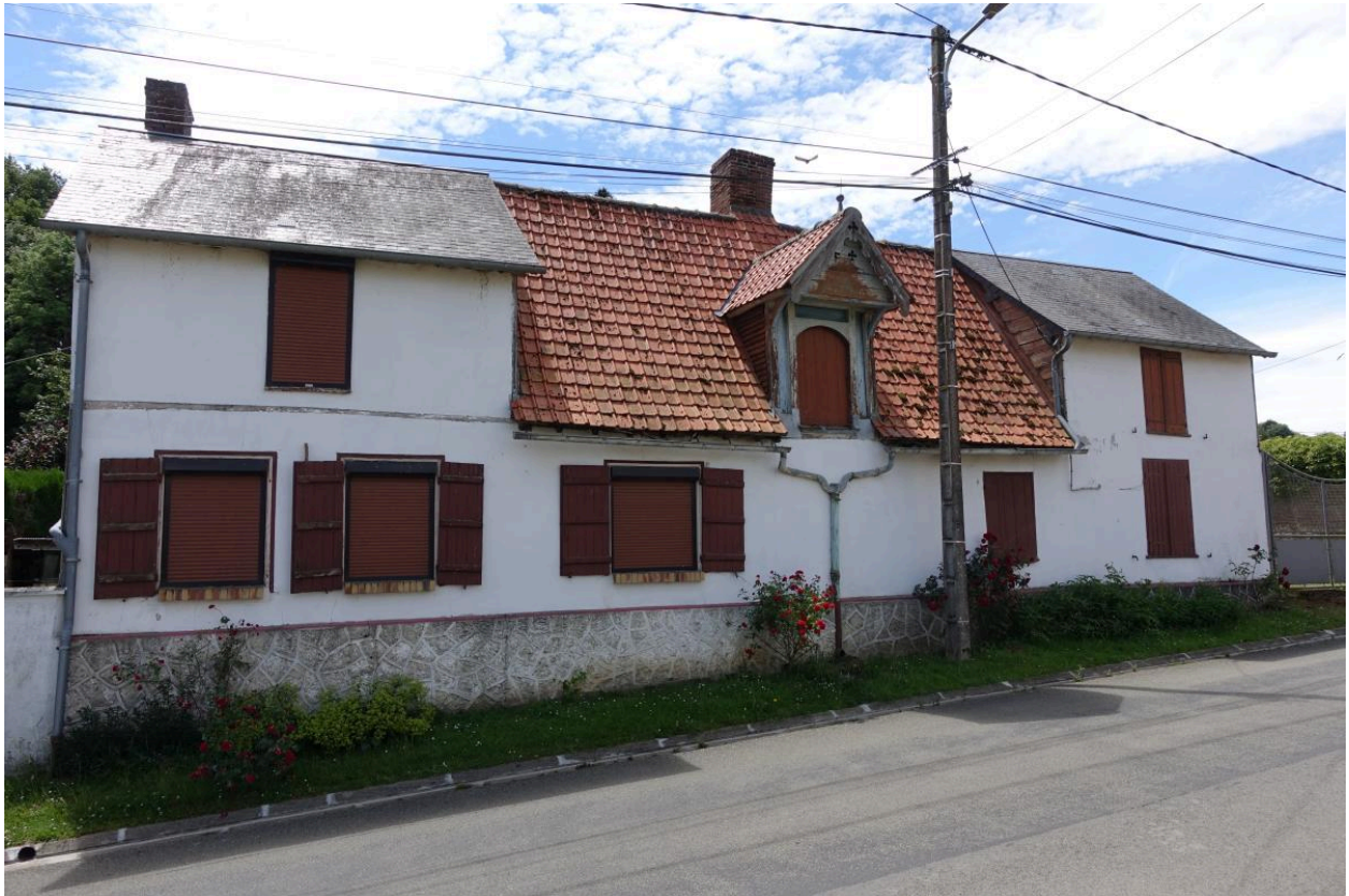
Maison d'artisan, n°18 rue Marcel-Dassault, vue depuis le nord.
