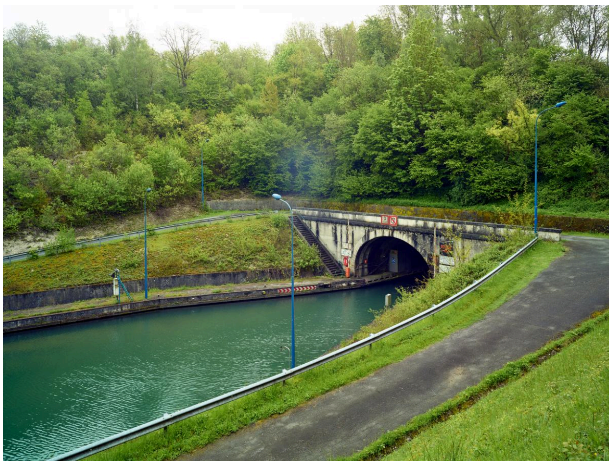
Tête nord et voie de circulation.
