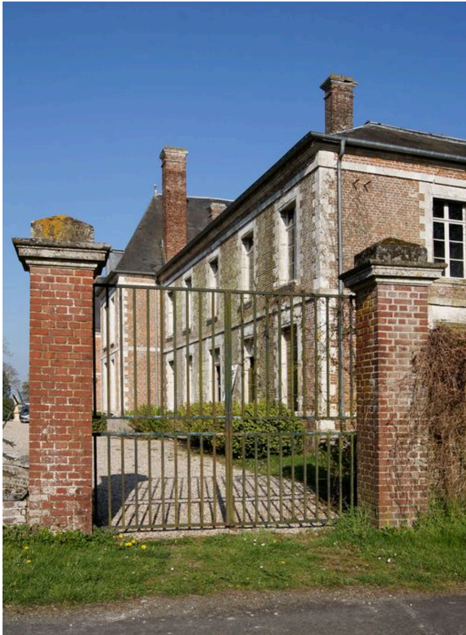
Portail latéral sur la cour.
