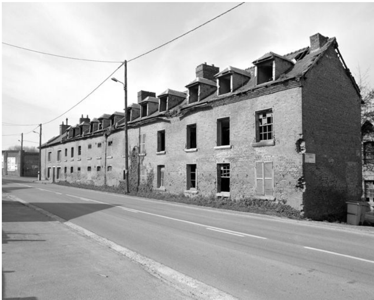
Logements ouvriers, élévation antérieure.
