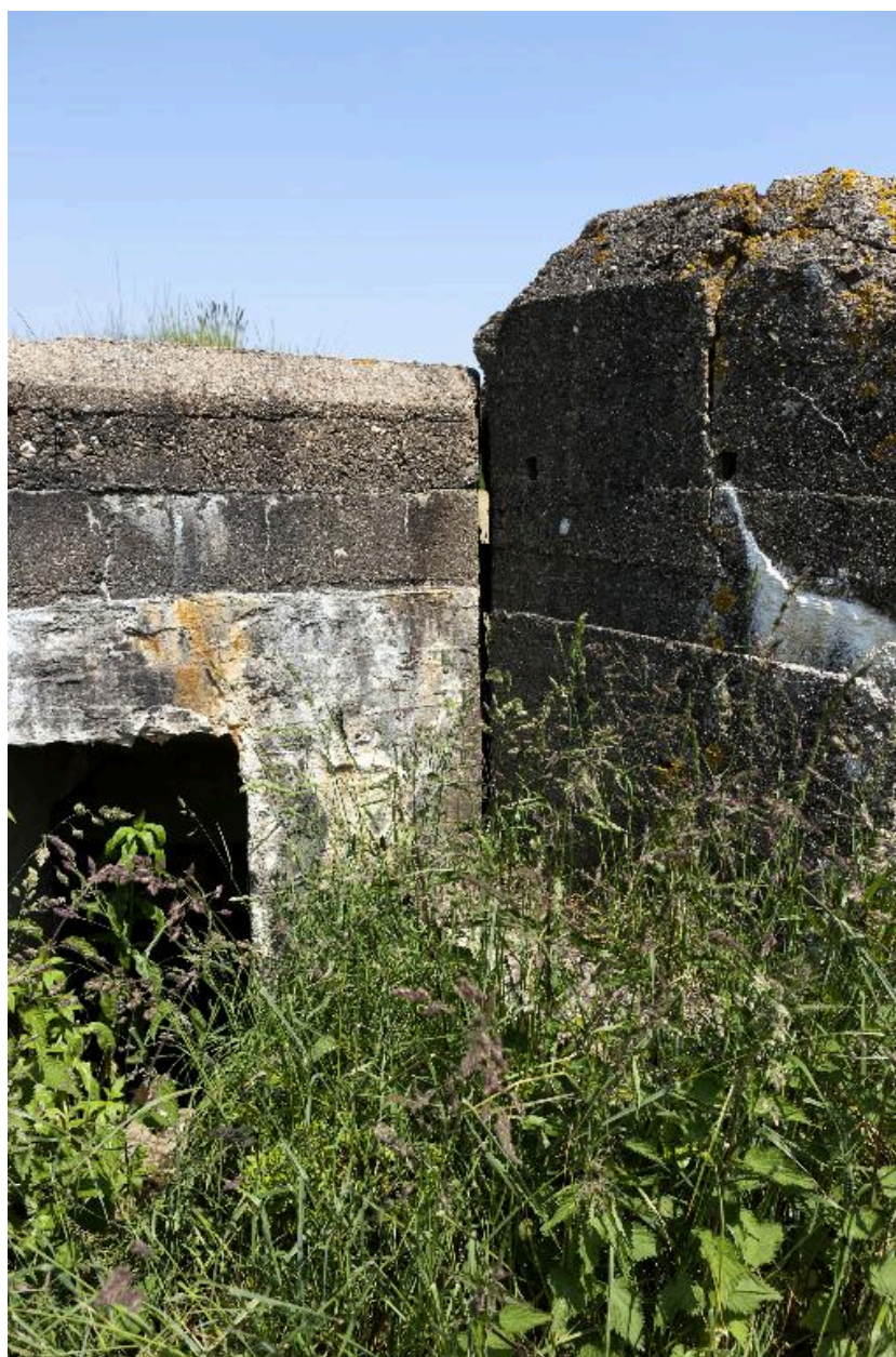
Jonction de l'abri avec l'observatoire casematé
