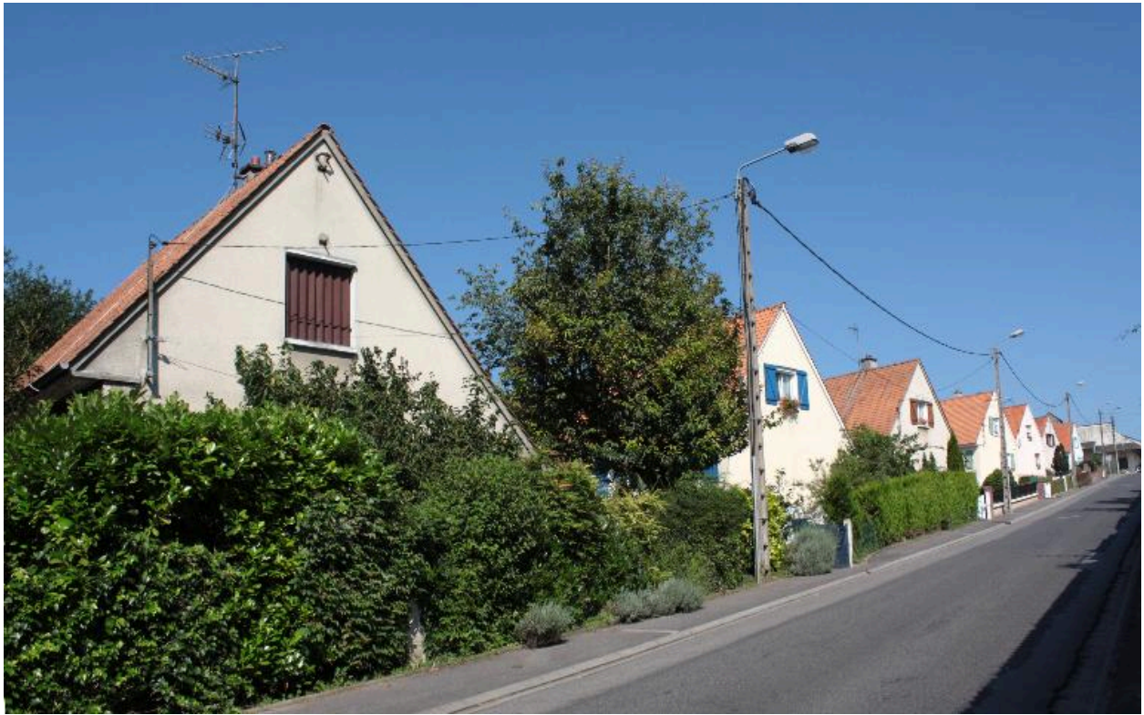
Maisons de cadres Saint Frères construites entre 1954 et 1958. (rue Chanzy).
