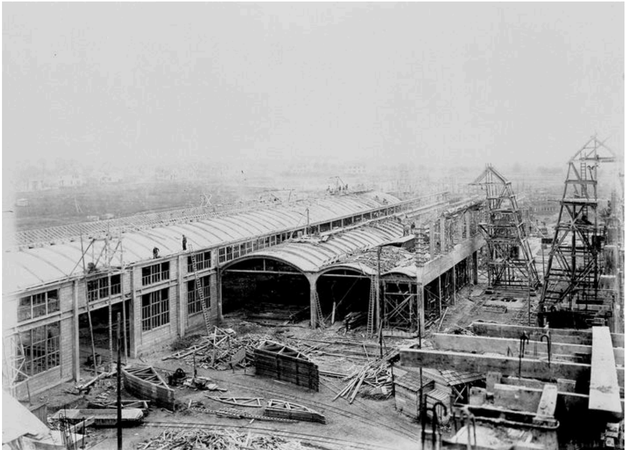
Construction des ateliers de fabrication, vers 1925 (AP).
