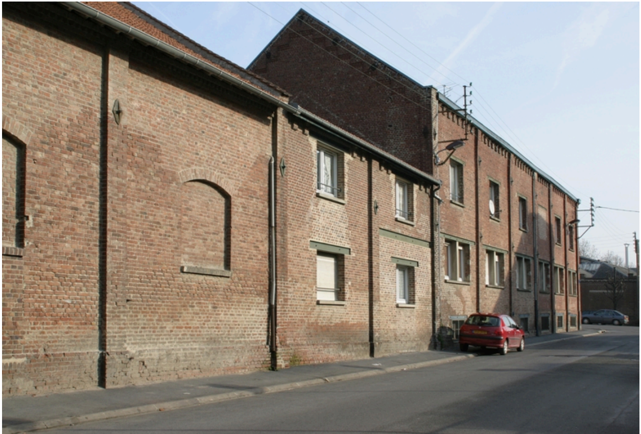
Anciens ateliers de bobinage et de retorderie, rue de Vicq.
