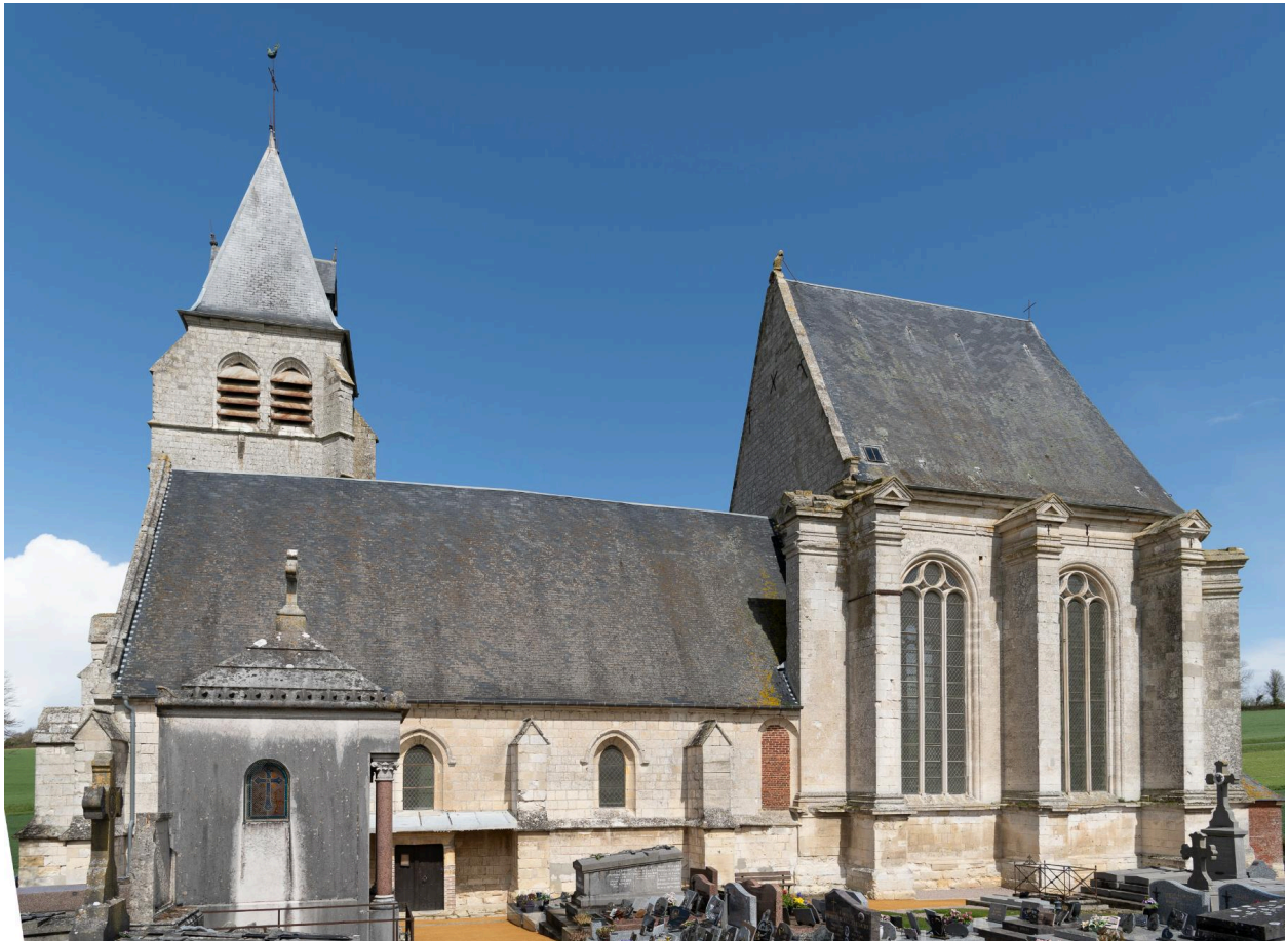
Vue générale de l'élévation sud.
