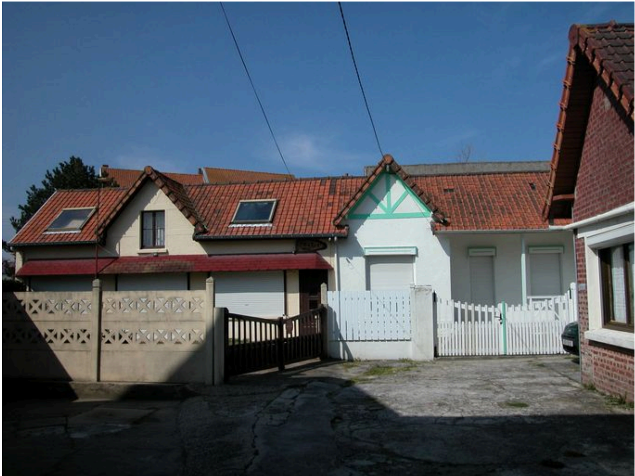
Vue d'ensemble depuis la rue.
