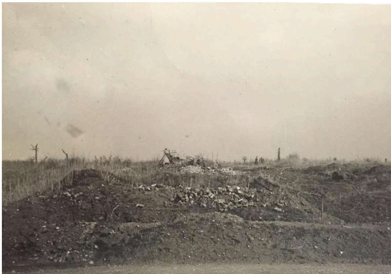
Emplacement de l'usine. 5 décembre 1918 (AD Somme ; 10 R 343).
