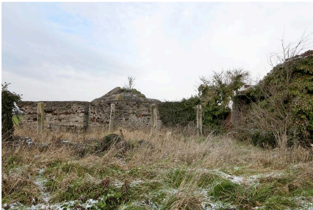
Ancien mur du corps de ferme duquel dépasse le dôme de la caemate nord
