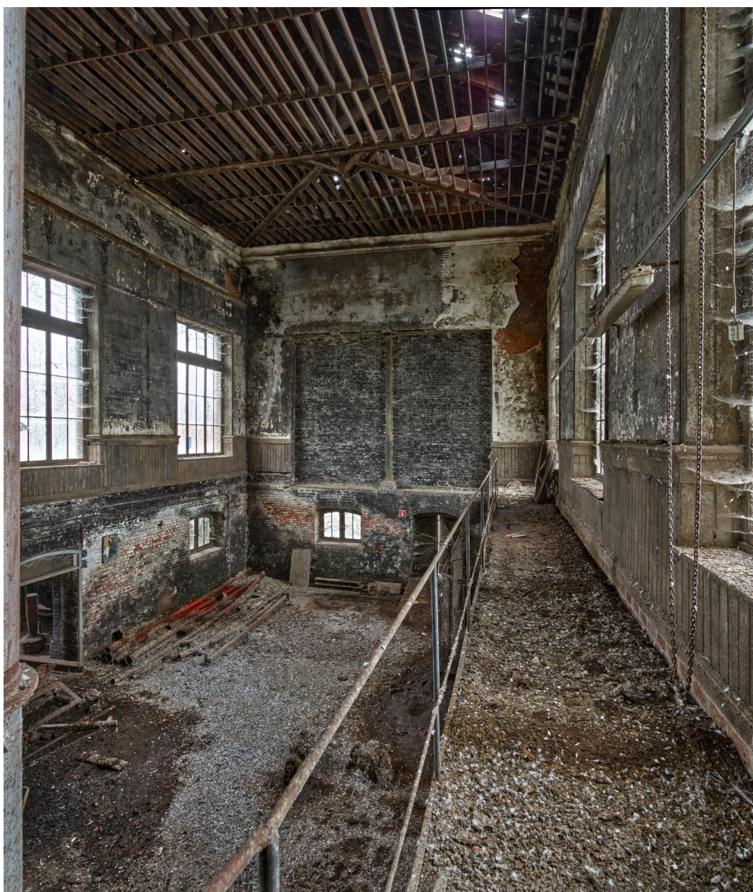
Vue intérieure de la salle des machines.
