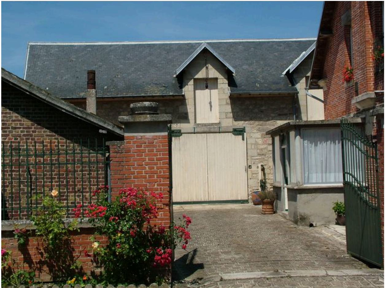
Vue de la grange.
