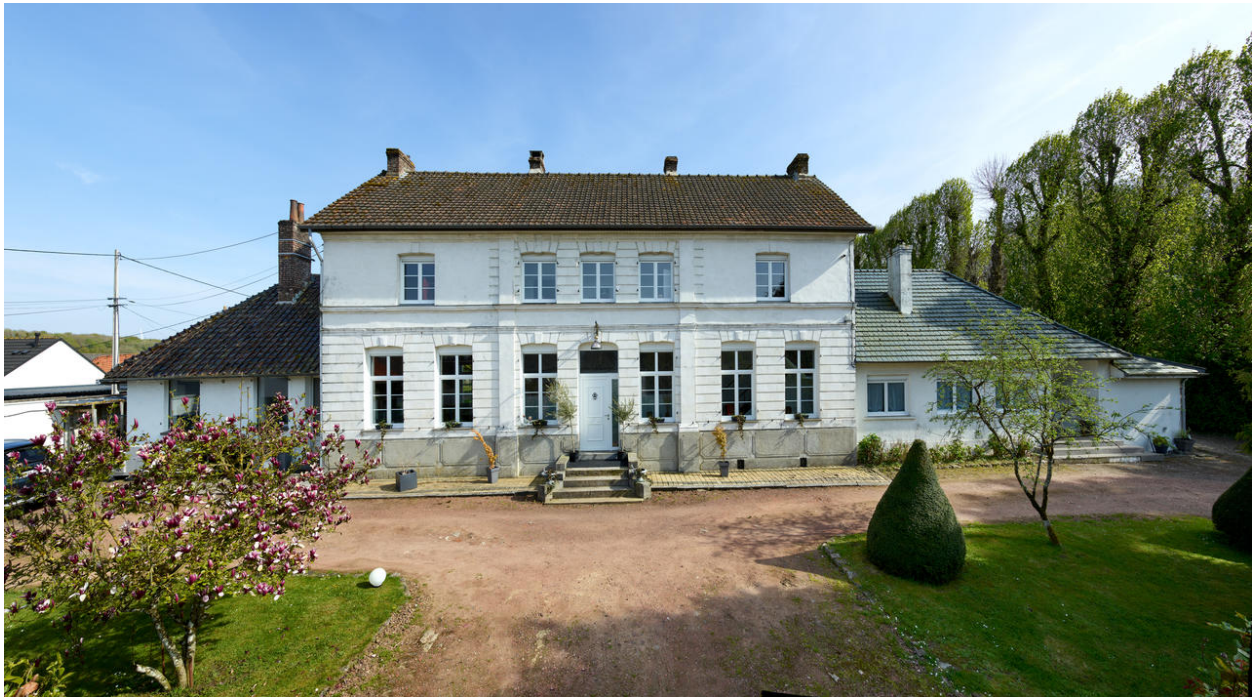
Vue générale de l'élévation nord.
