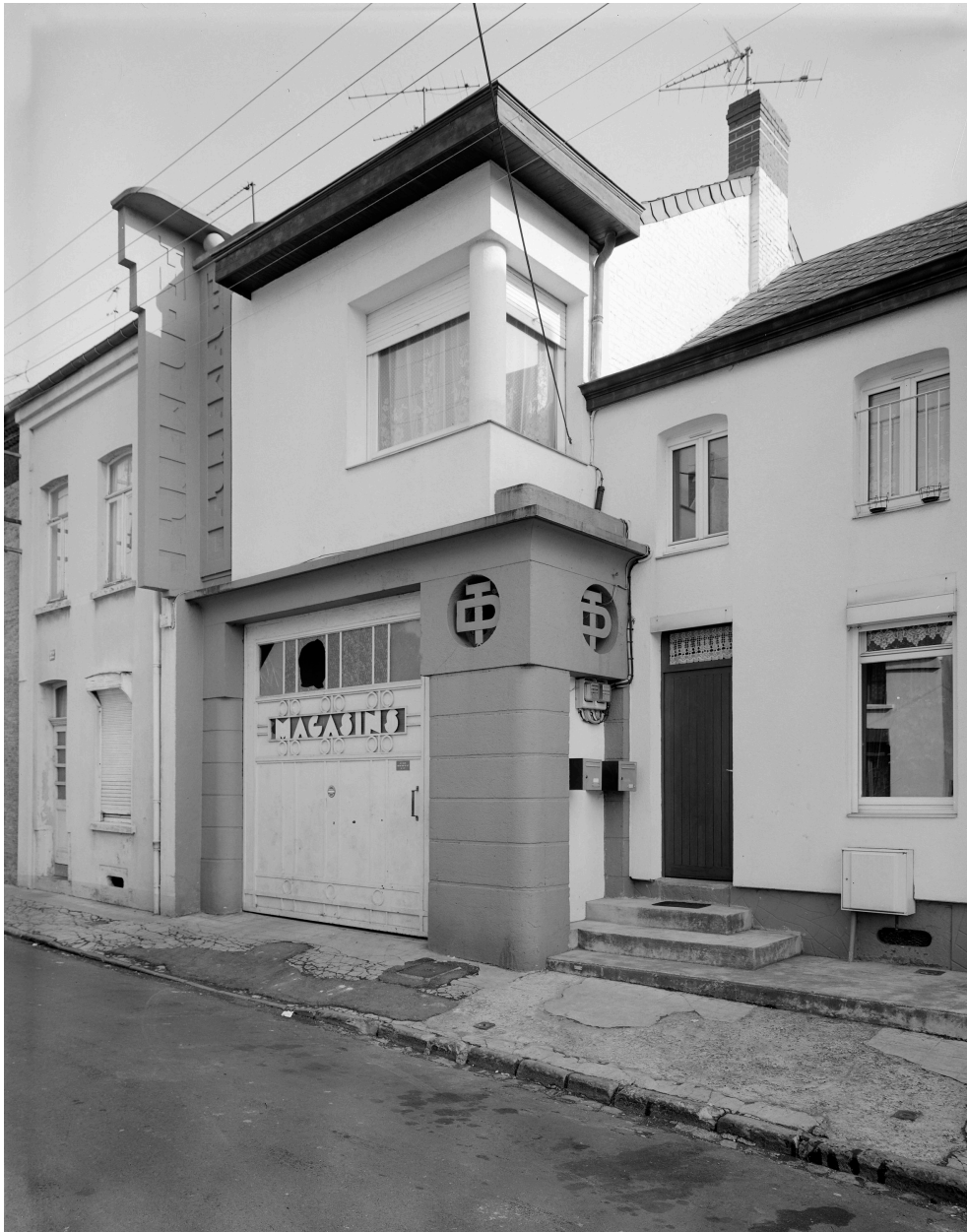
Élévation antérieure, habitat et entrepôt commercial.
