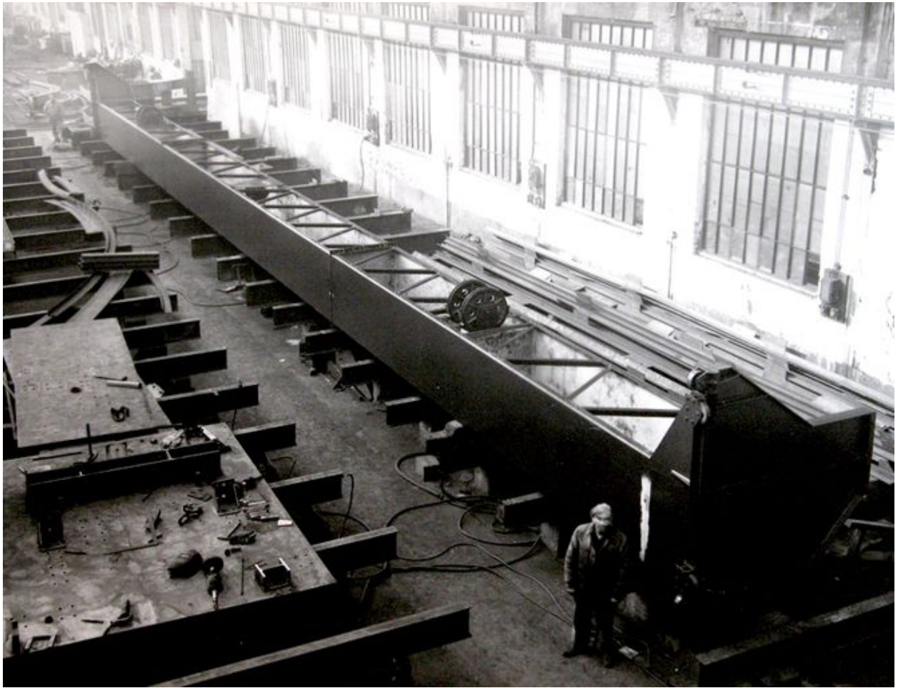
Batardeaux, chute de Baix (Ardèche), 1961 (collection particulière).
