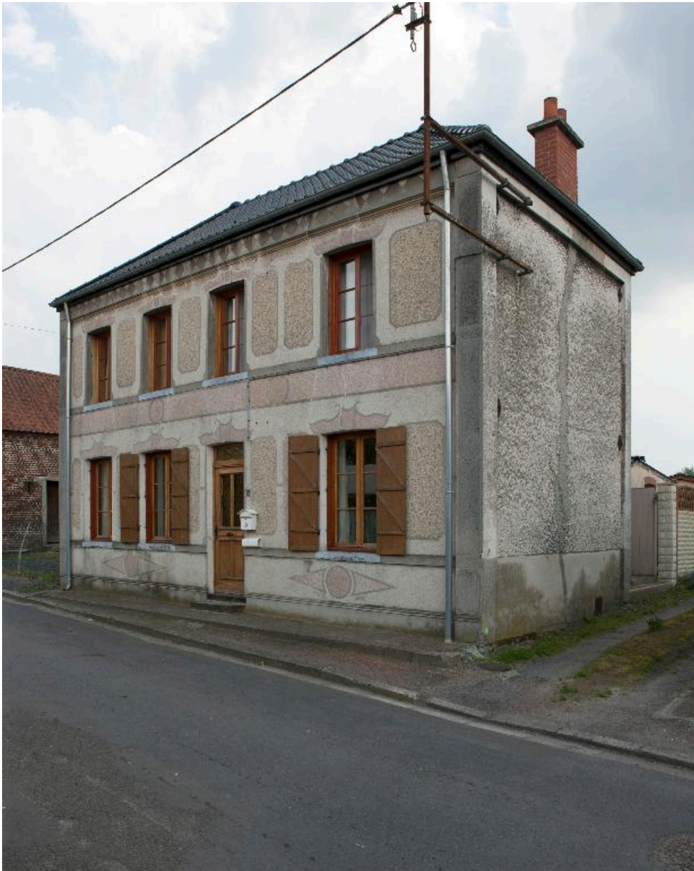
Maison 12 rue du Cimetière.
