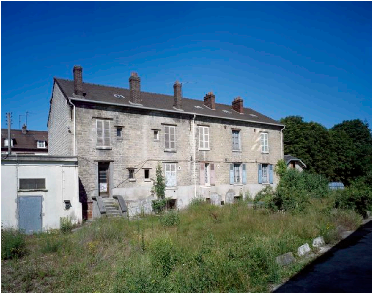
Vue générale de la façade postérieure de l'immeuble de logements d'ouvriers.
