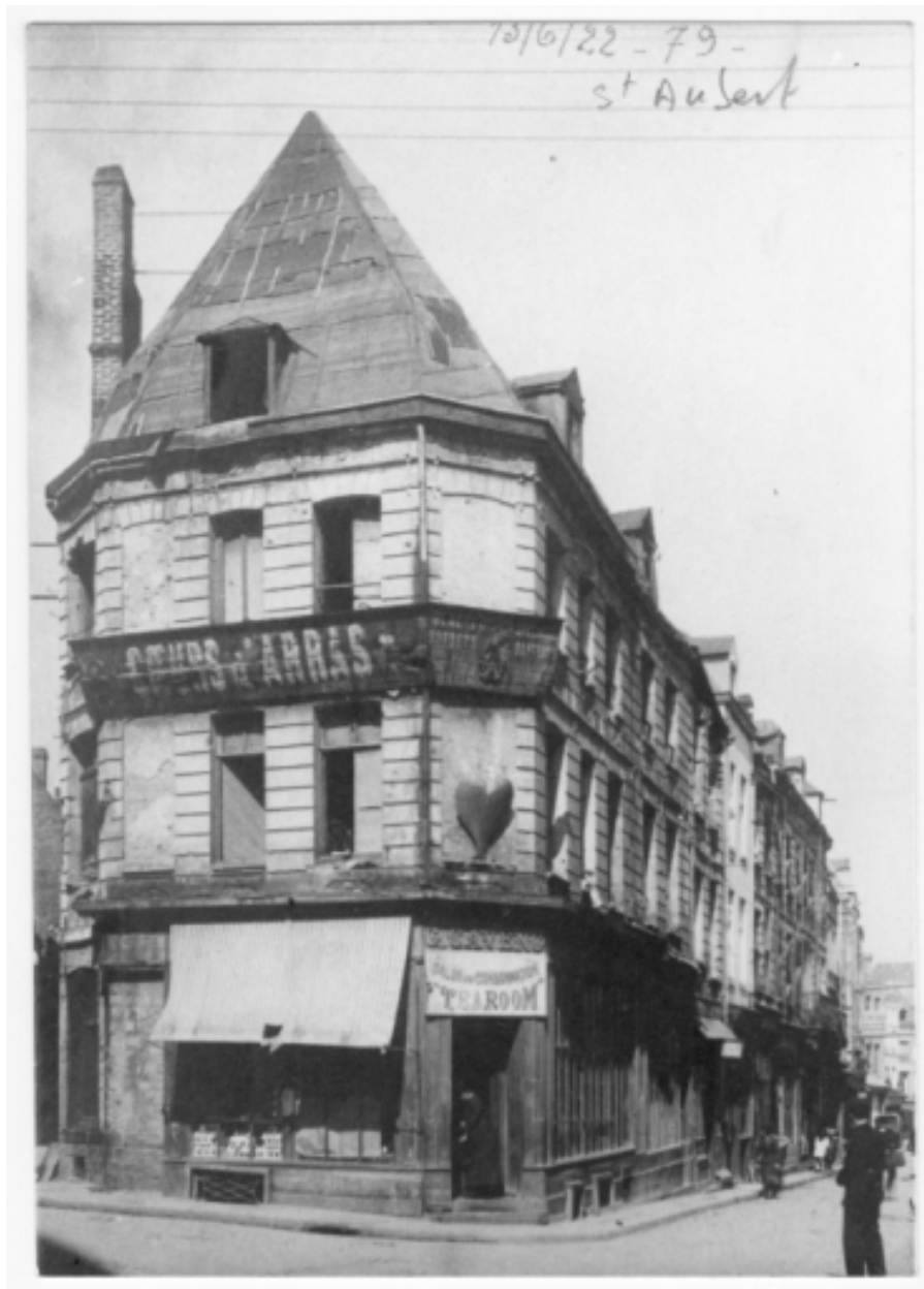
Vue de l'immeuble du 11-13 rue Saint-Aubert, construction avant l'alignement de la rue.
