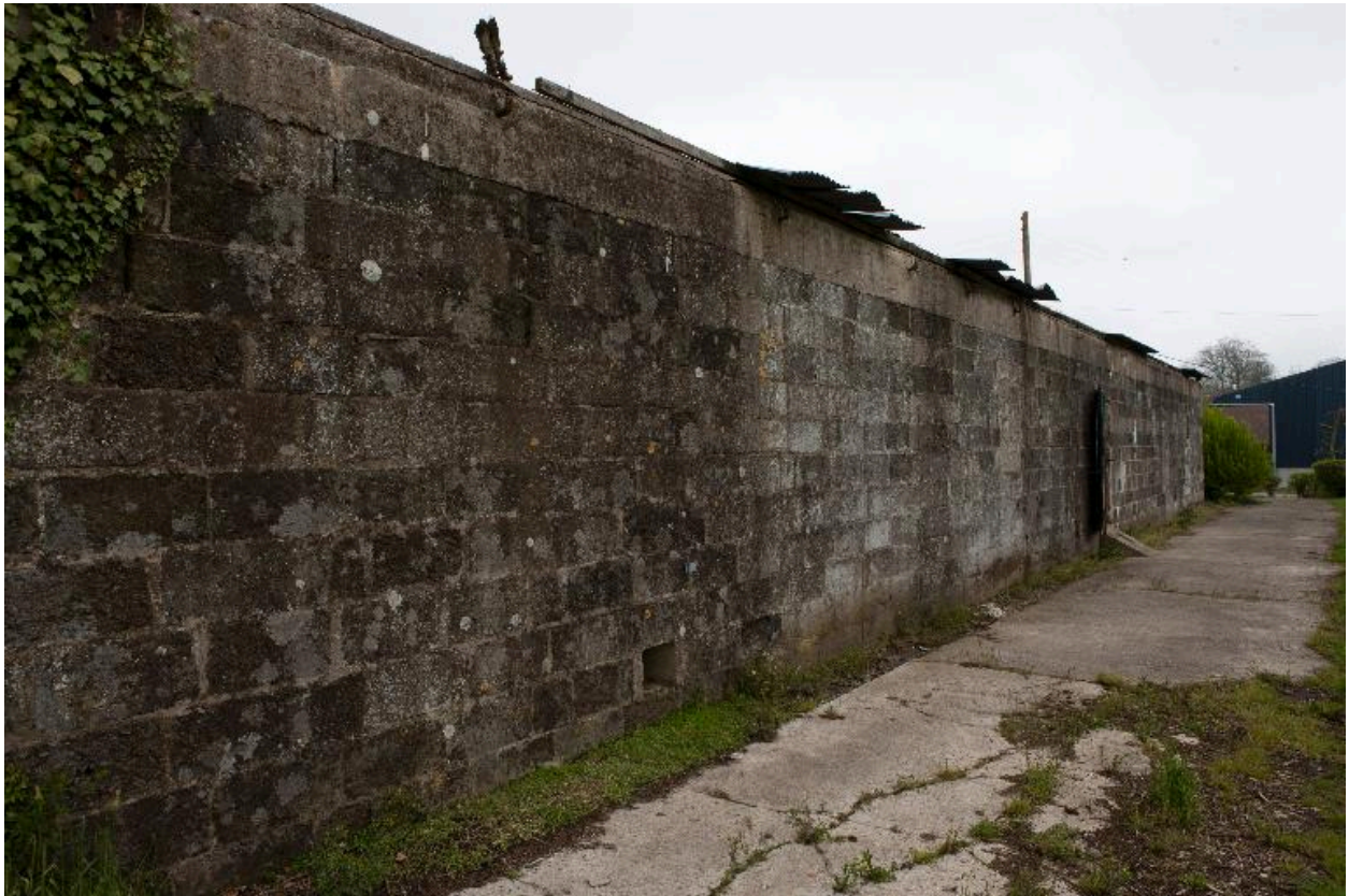
Bâtiment de stockage d'attente. Détail de l'élévation.
