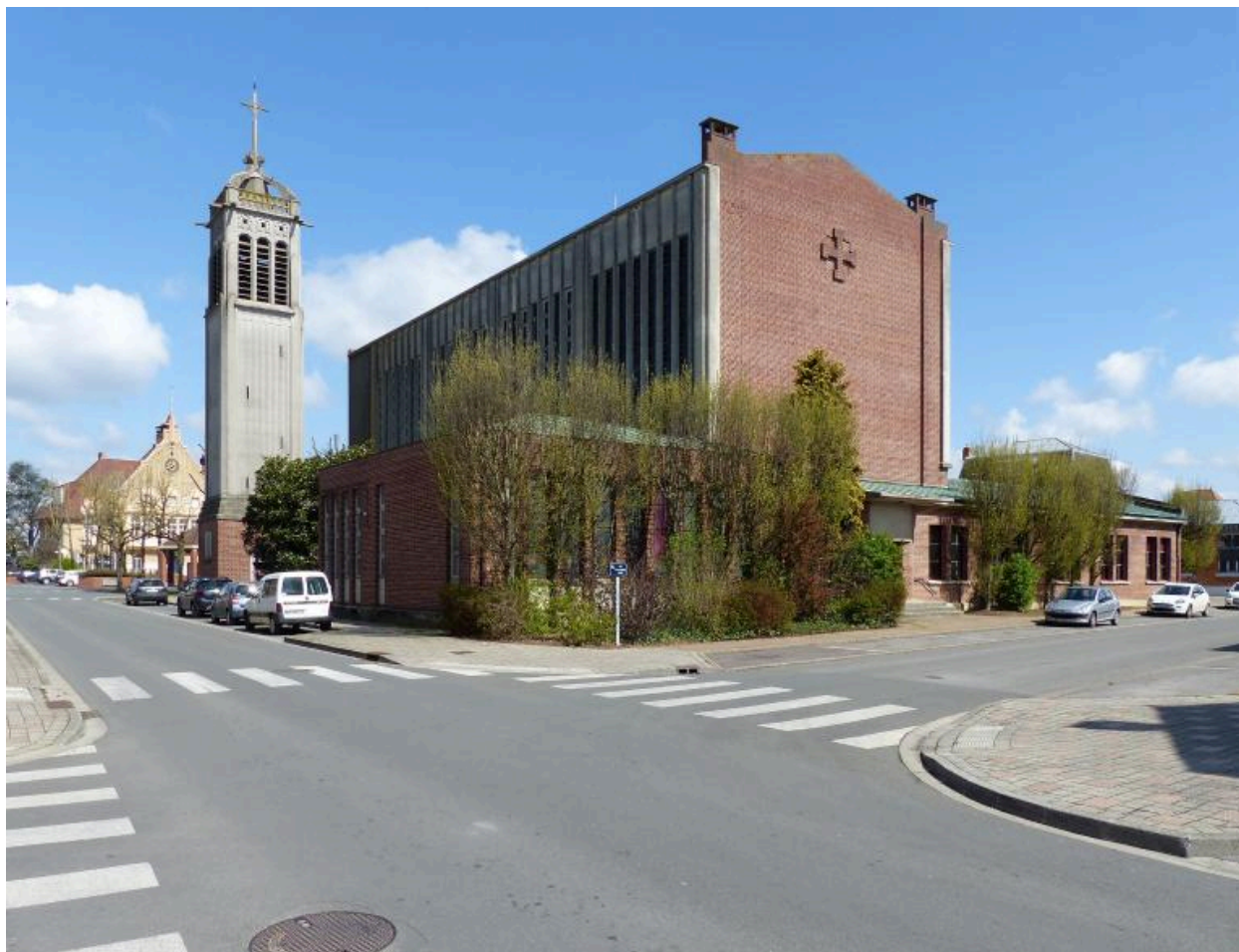
Vue générale, depuis le sud-ouest.
