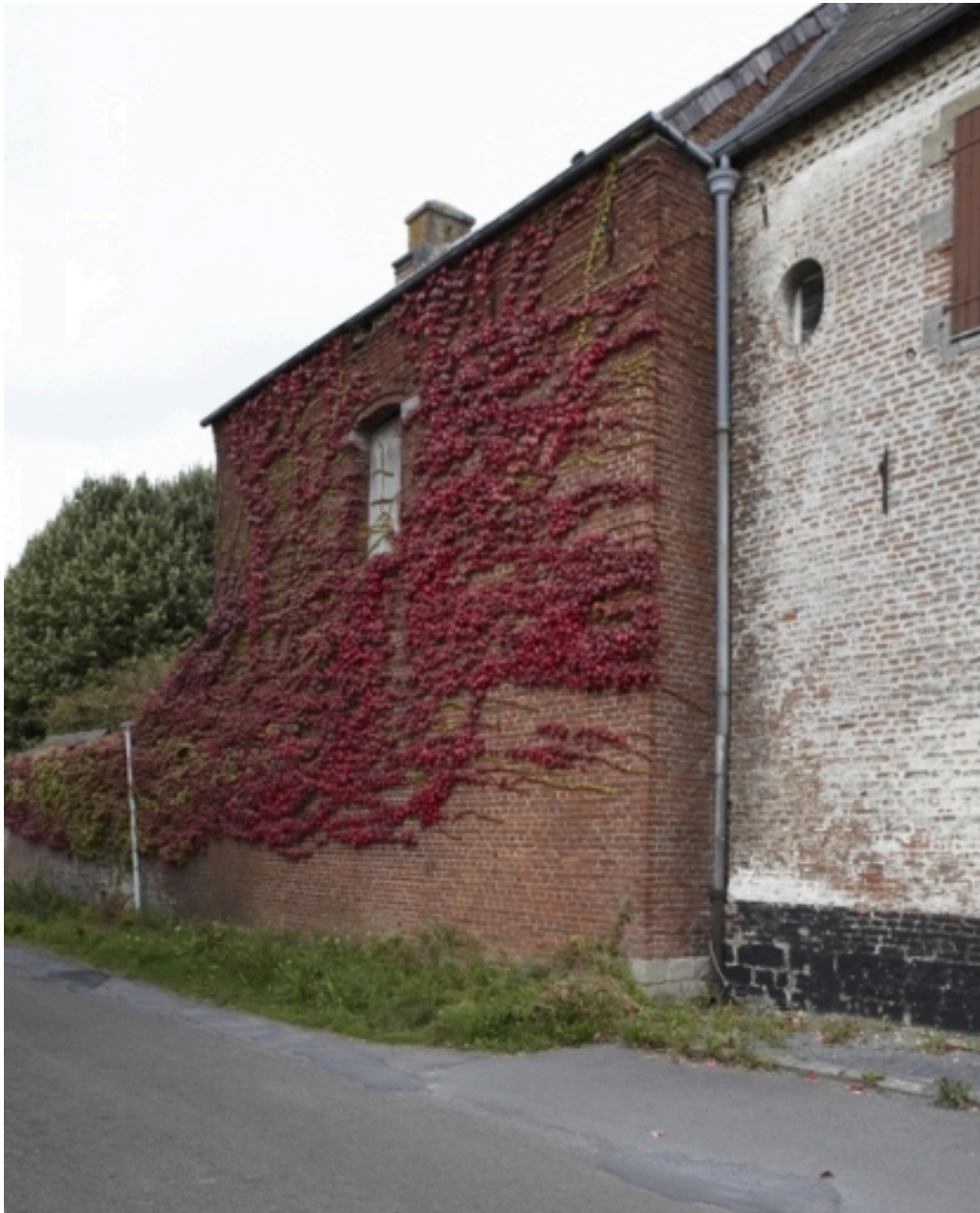
Vue de l'élévation sur rue des écuries.
