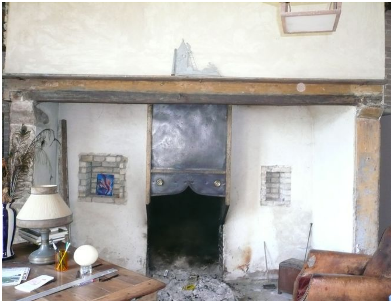
Vue d'une cheminée entièrement en brique avec corbeaux en grès, muni d'un foyer à la prussienne.
