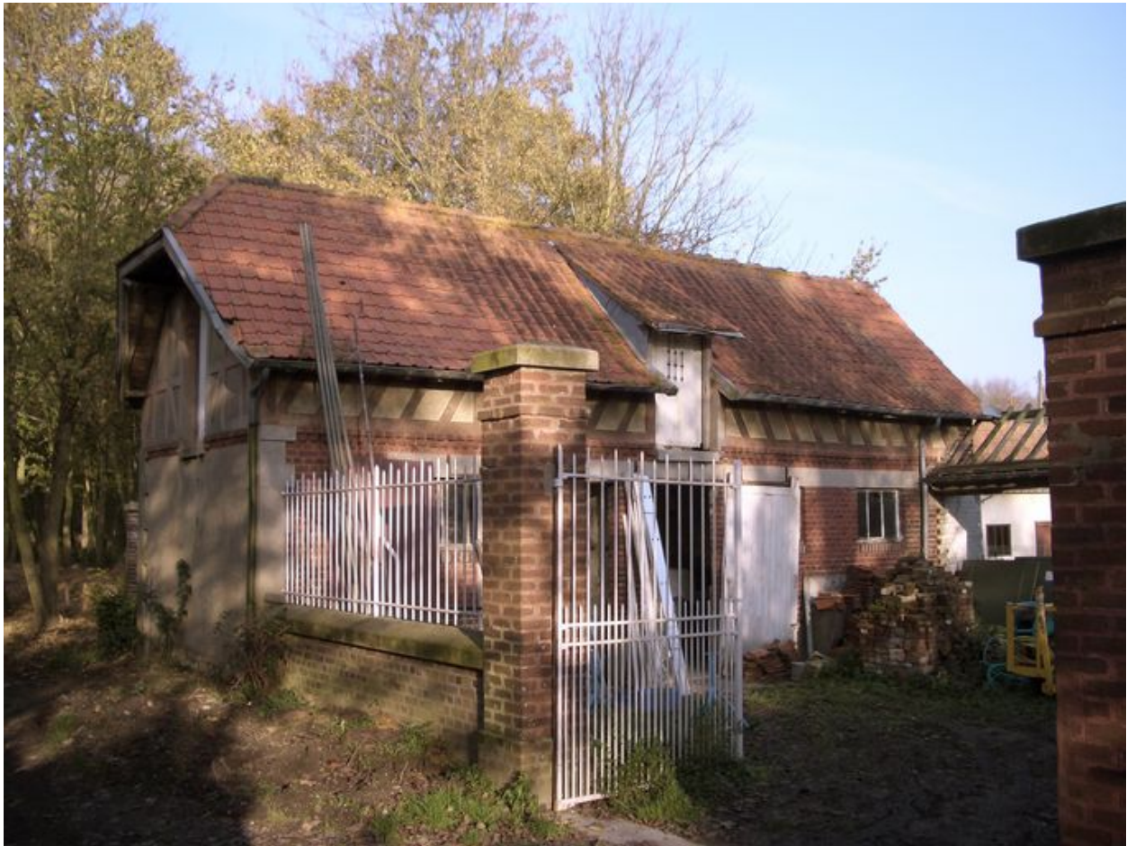
Vue des dépendances agricoles situées à l'est de la propriété.
