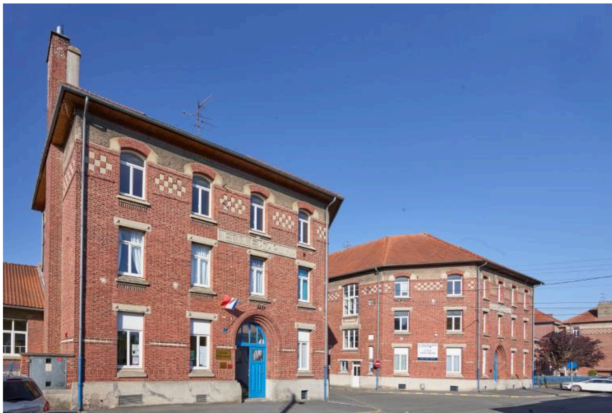
Vue des pavillons Carlin et Legrand, boulevard des Ecoles.
