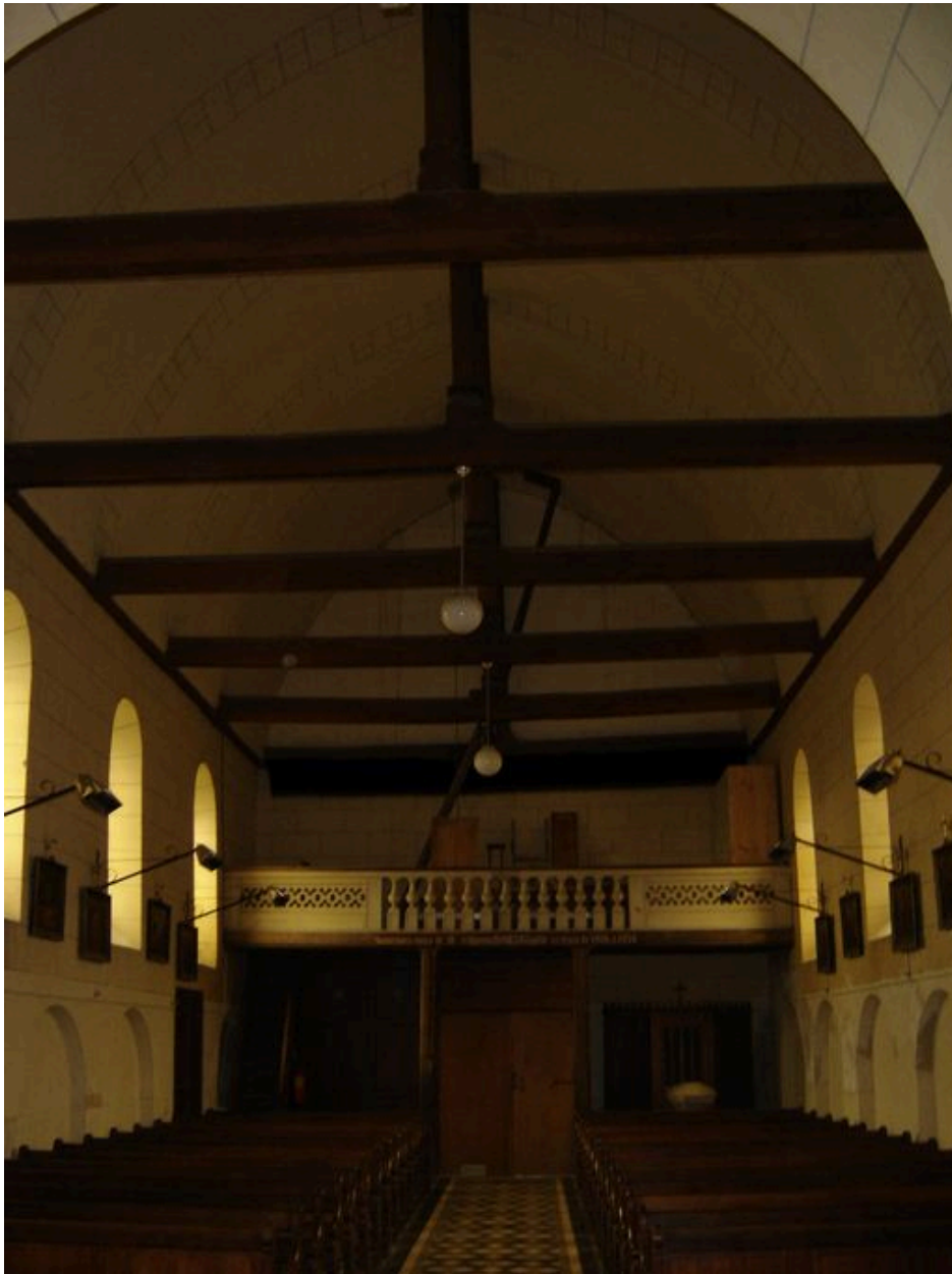
Vue intérieure de la nef.
