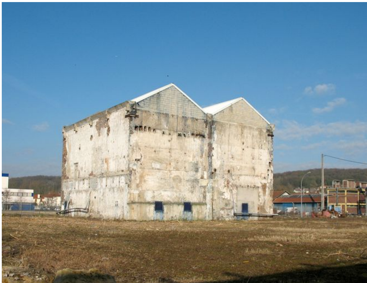
Bâtiment n°1 (atelier de colorants) sur la plate forme chimique de Villers Saint Paul.
