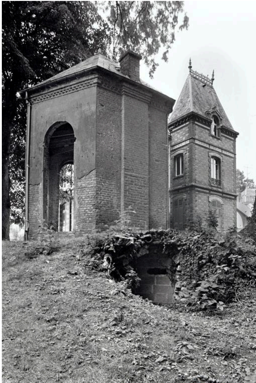
Vue du kiosque de la maison.
