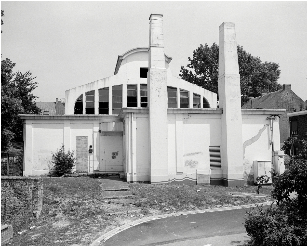
Élévation latérale vers l'est et la chaudière au premier plan.
