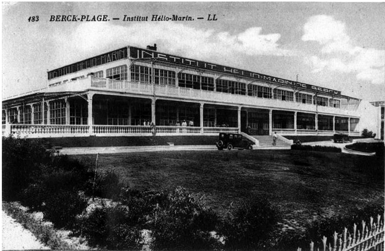
Bâtiment affecté aux hommes dit Institut hélio-marin A, élévation antérieure, vue générale prise de trois-quarts gauche. Carte postale, années 1920-1930.
