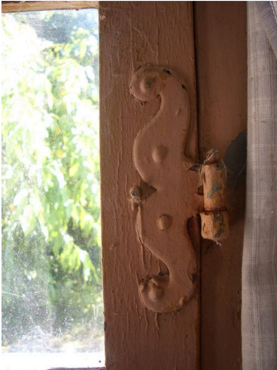
Détail de la ferrure de fenêtre à profil dit de vipère ou de moustache.
