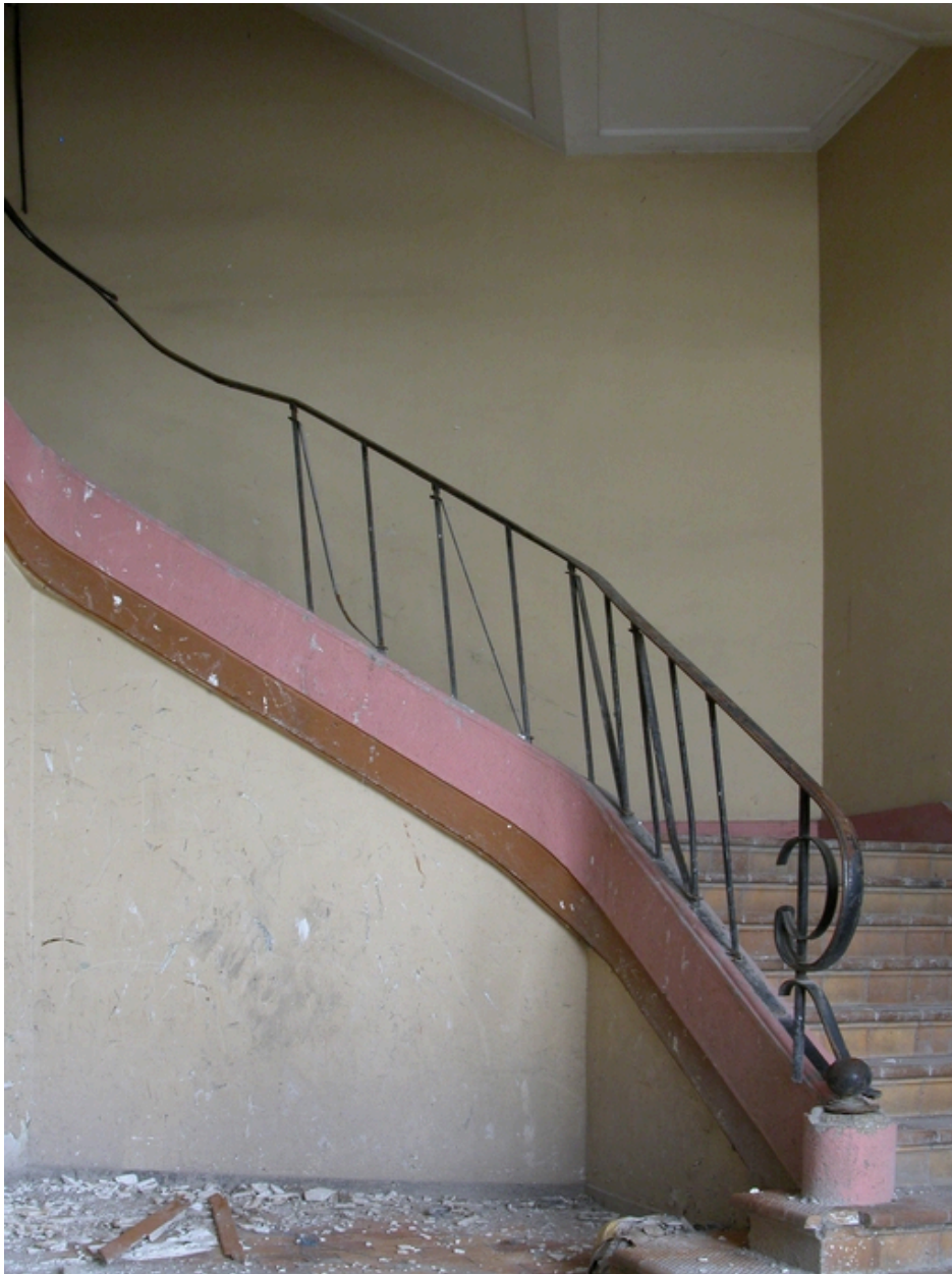
Escaliers des ateliers des années 1946-48.
