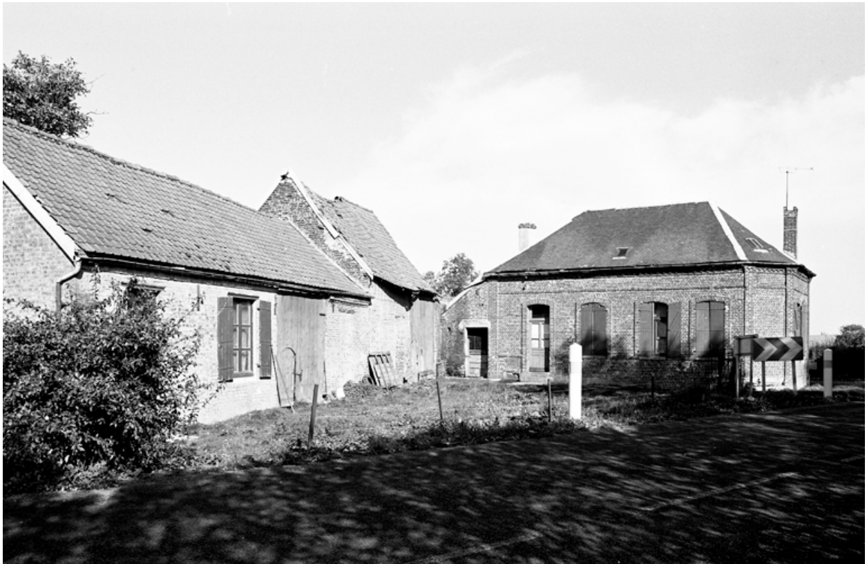
Troisième ferme : vue d'ensemble depuis le sud-ouest.
