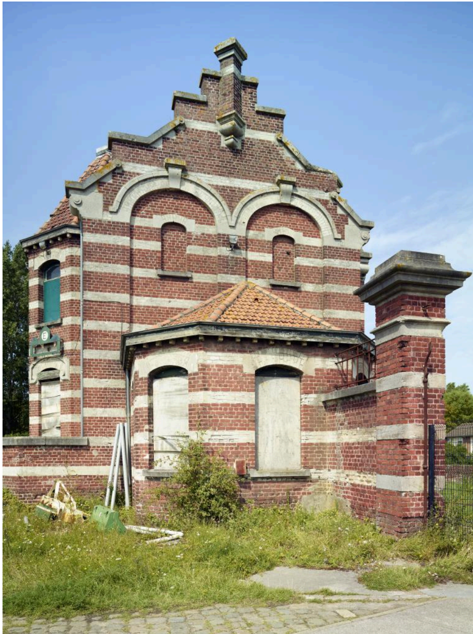
Maison du chef d'élevage, vue du pignon sud.
