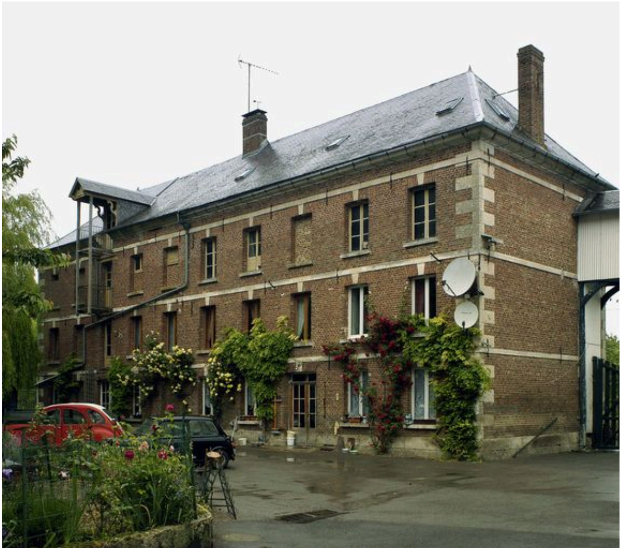
Façade sur cour de la minoterie.
