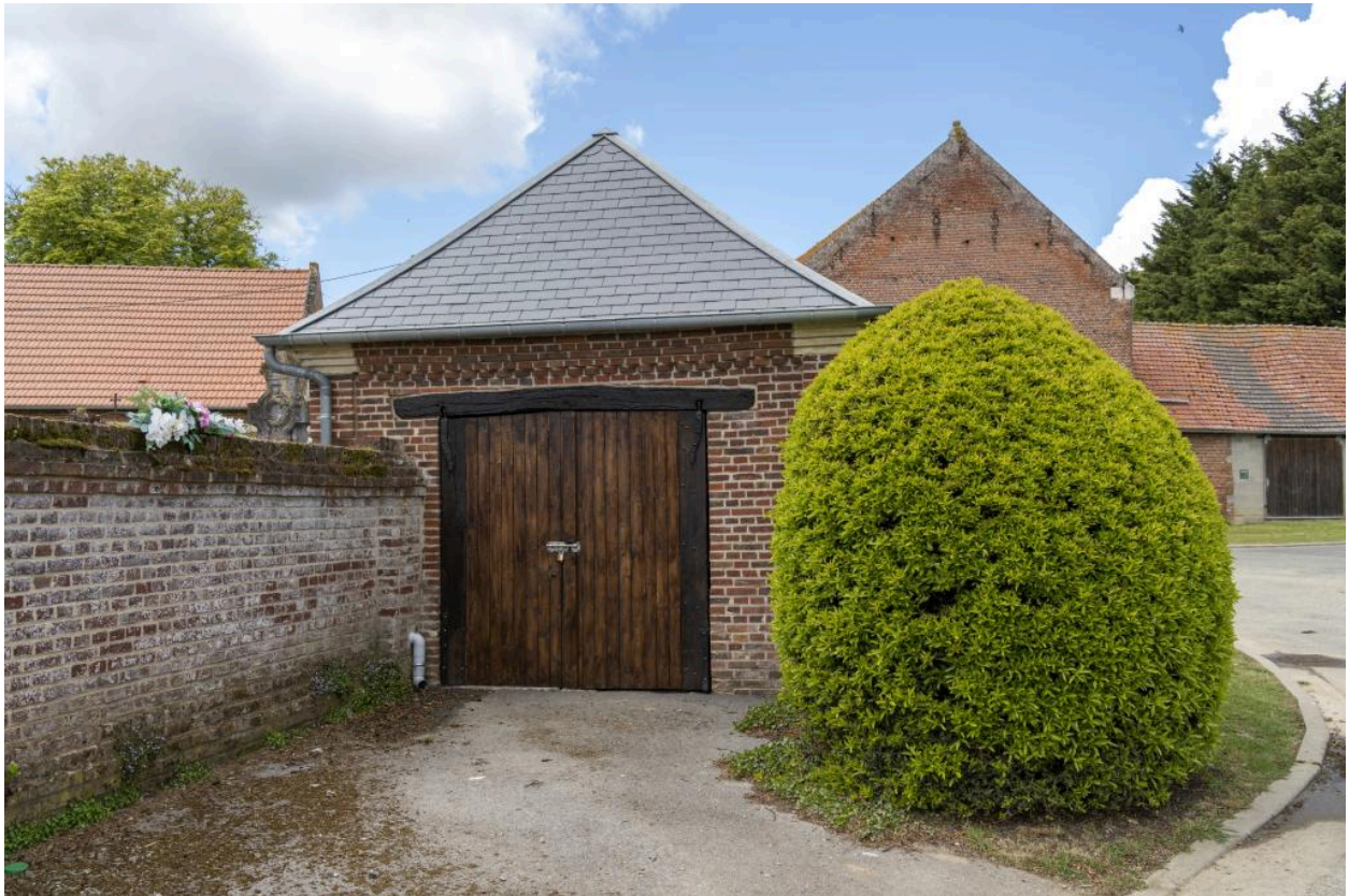
Bâtiment des pompes à incendie, vers 1901.
