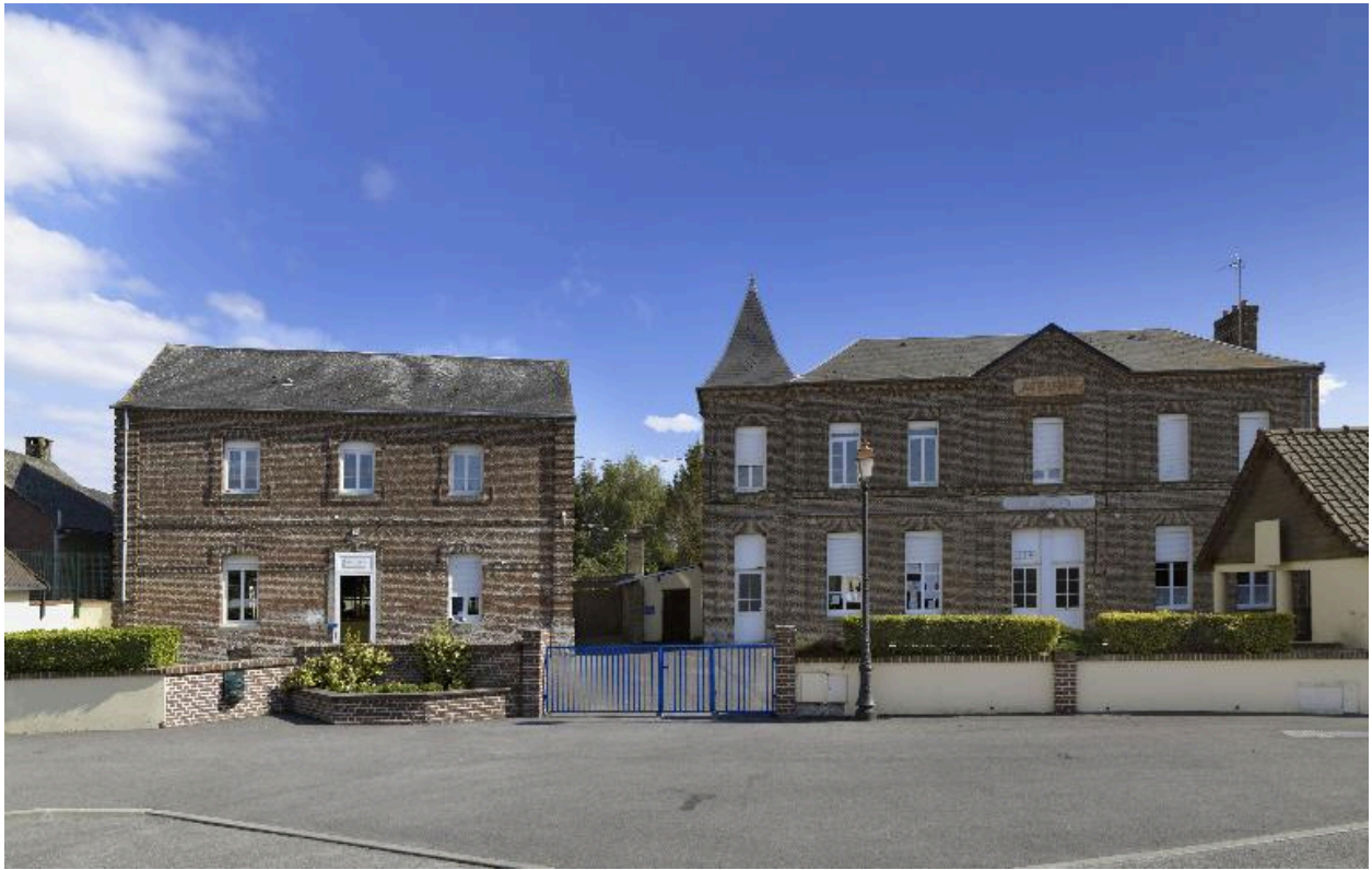
Vue générale depuis la place du Général Leclerc.
