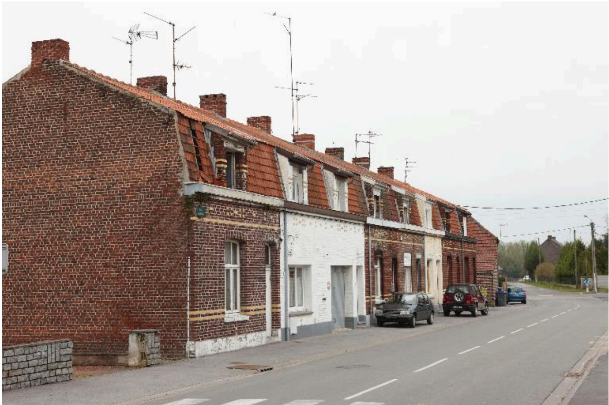
Maisons ouvrières en série, 22-36, rue de Maulde.
