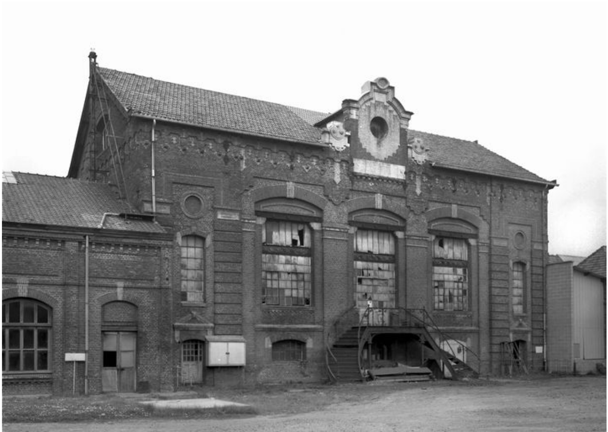
Salle des machines (bâtiment 7), en 1988 : élévation antérieure.
