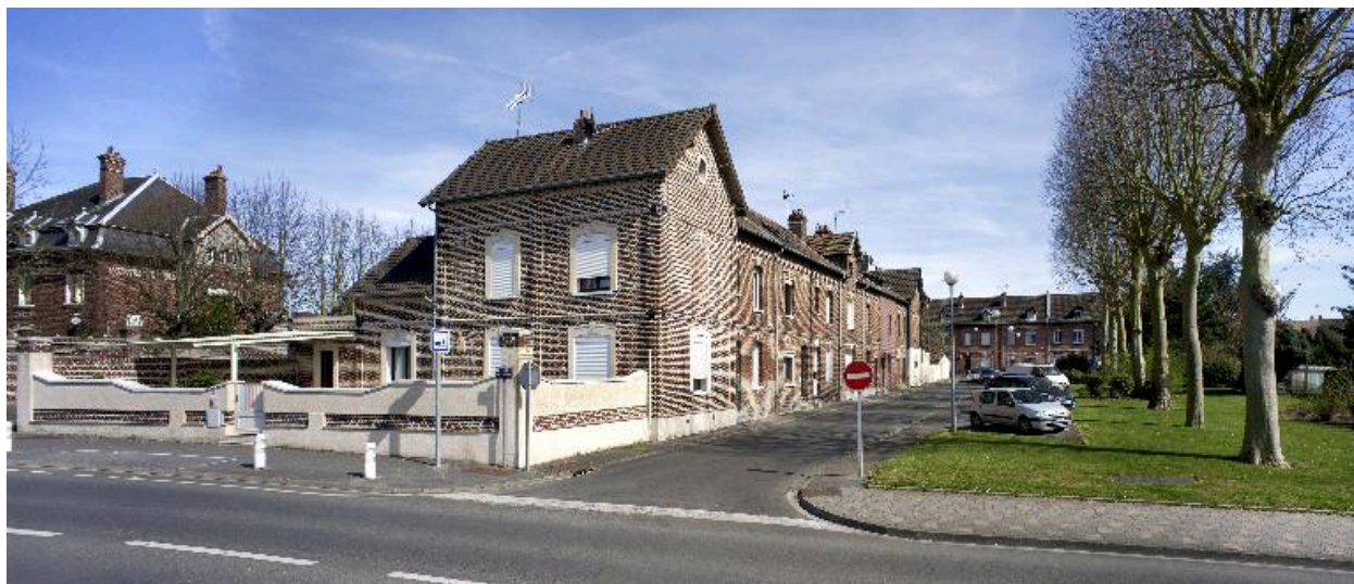
Vue générale depuis la rue Vaucanson.
