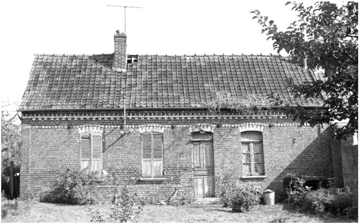
Façade antérieure, sur rue.
