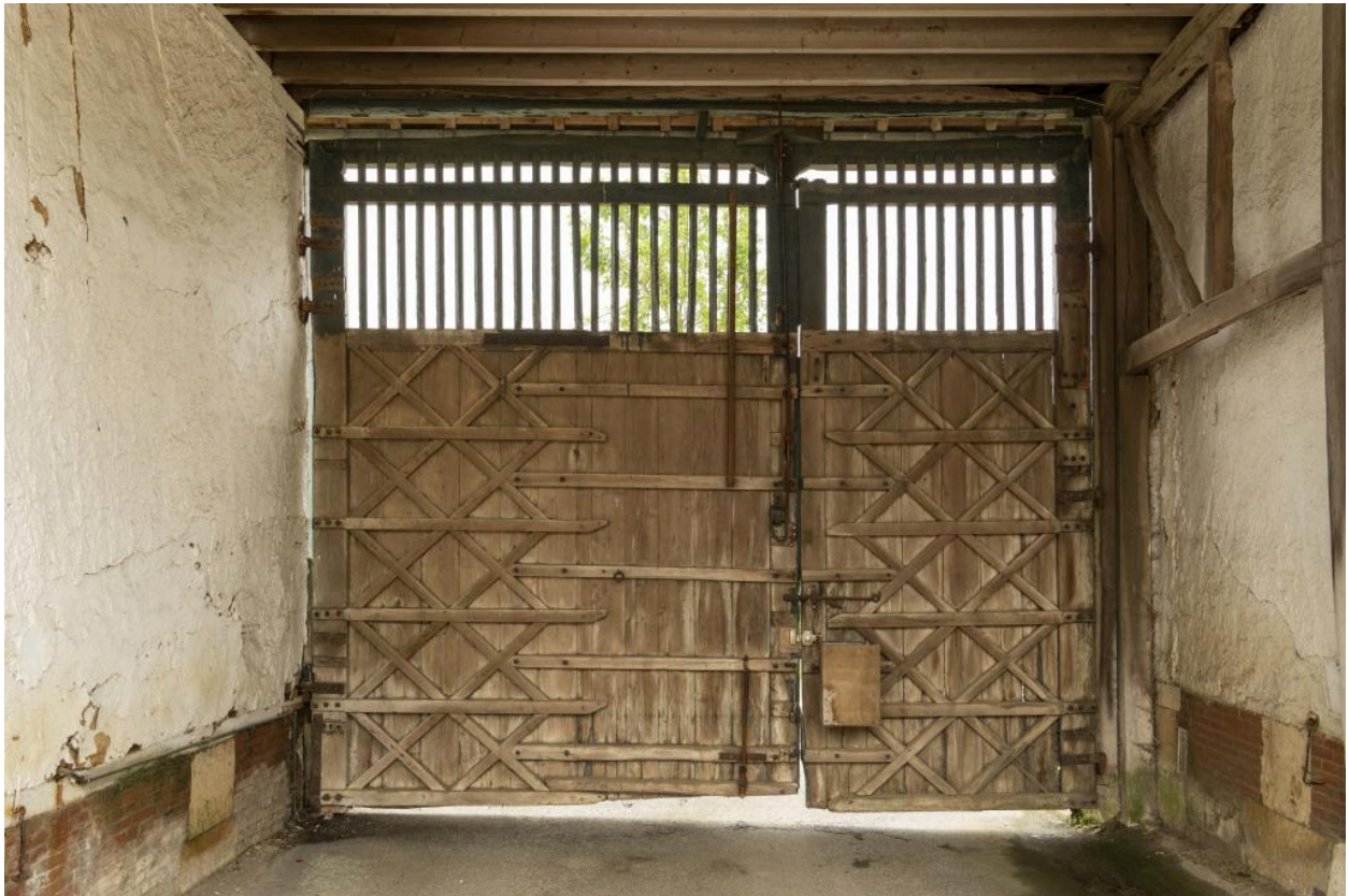
Revers de la porte de la charreterie, 4e quart 19e siècle, vue depuis le sud.
