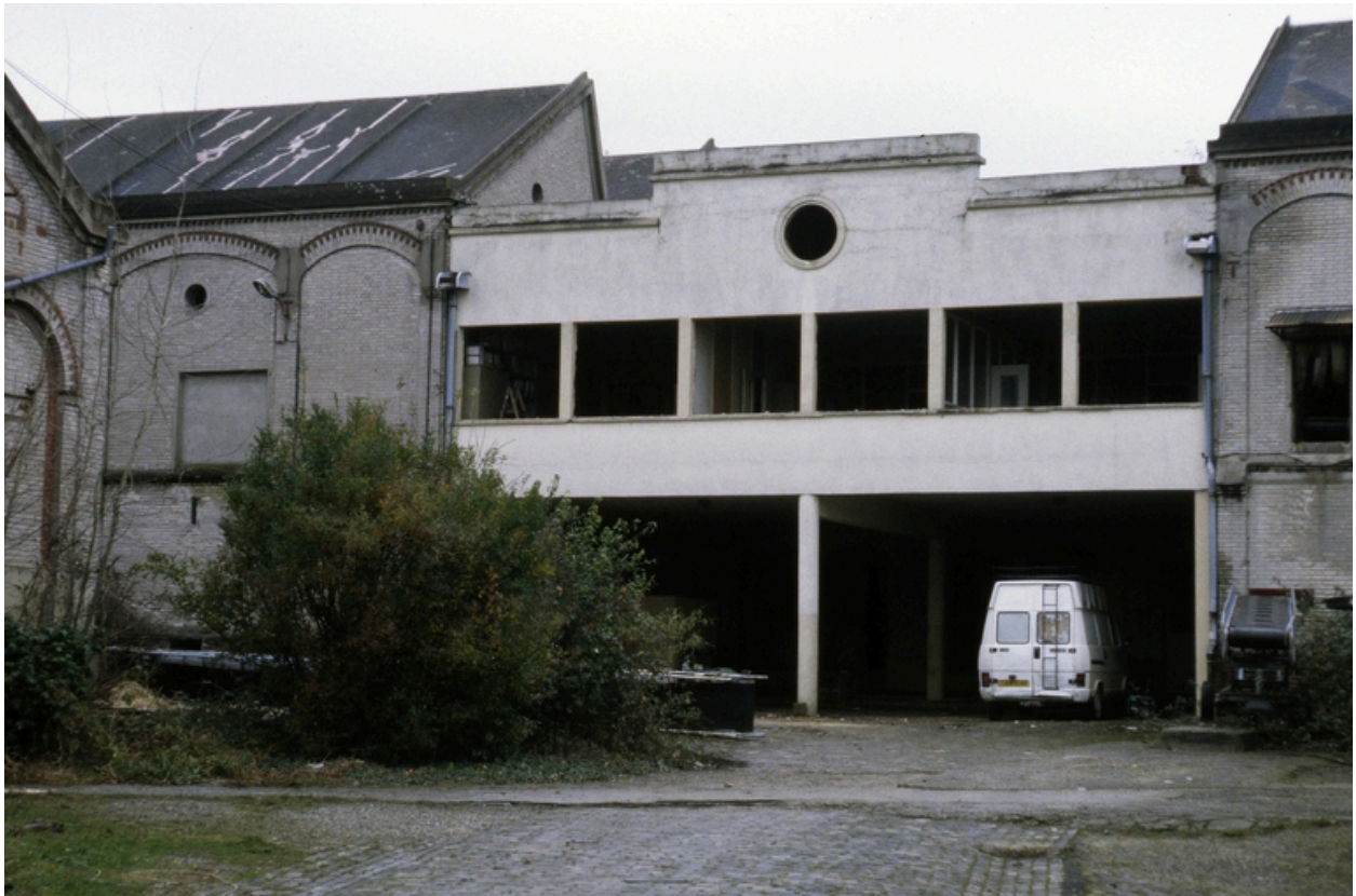
Façade sur cour des bureaux techniques situés au centre des ateliers de fabrication, 2001.
