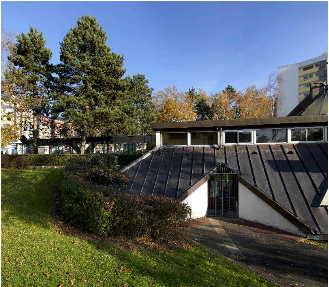
Vue de l'entrée au niveau inférieur.
