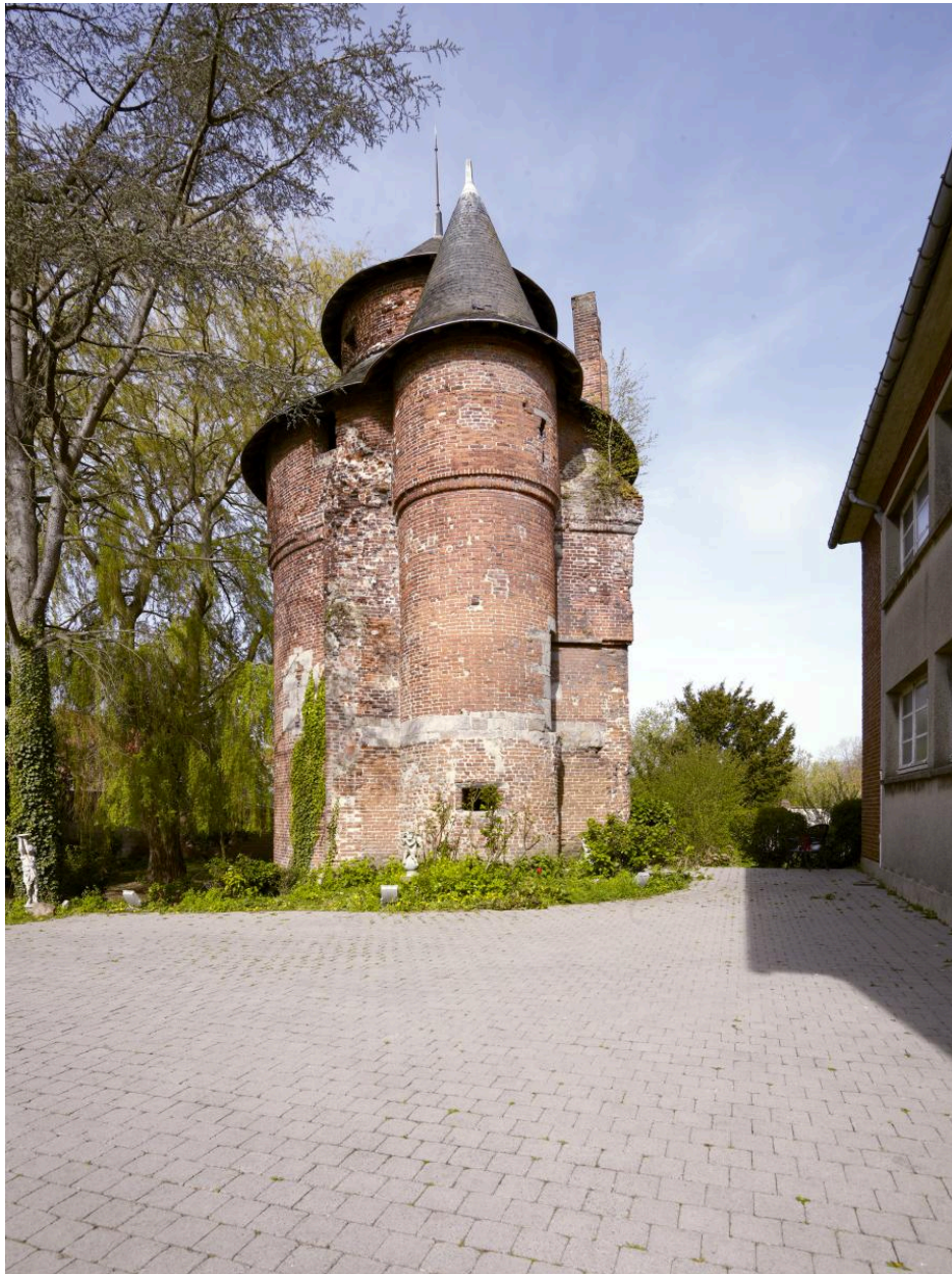
Vue générale de la tour prise depuis le sud-est.
