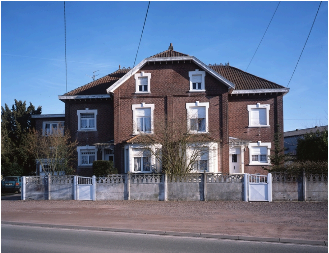
Vue générale des maisons d'ingénieur.
