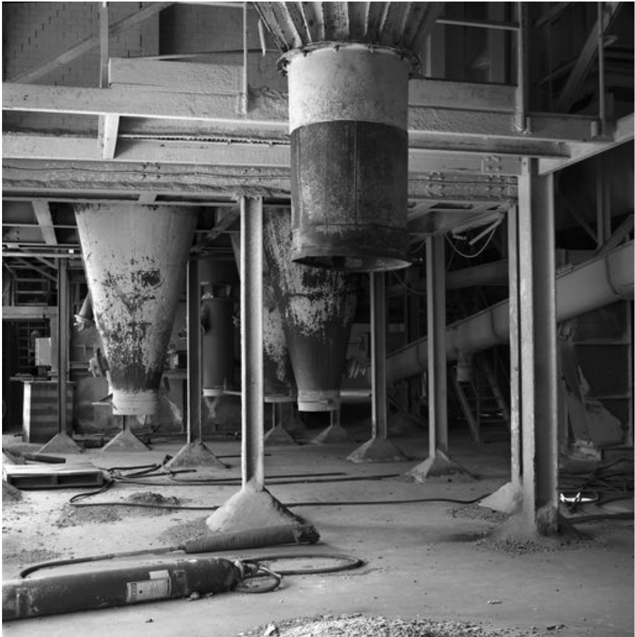
Trémies dans le bâtiment des fours.
